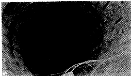
写真-2 西立坑ライナープレート建て込み状況
